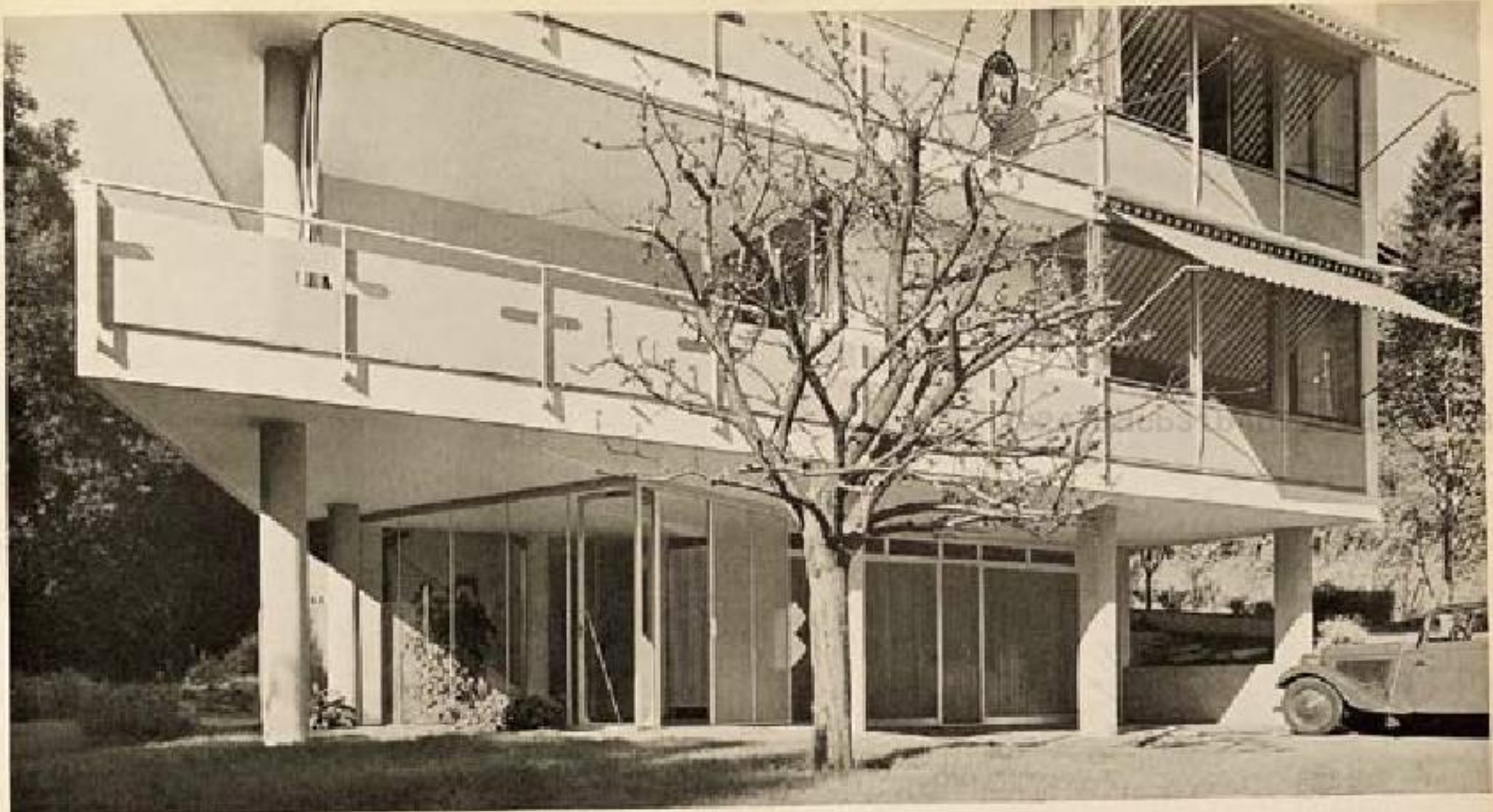
18. Teilansicht von Südwest mit Eingang und Garage
